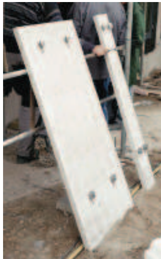
Bild 4: Zum Einhängen vorbereitete Fassadenelemente
