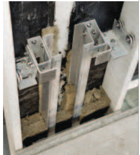
Bild 5: Die Laibungen der Lisene sind bereits eingehangen - es folgt das Einhängen der Lisenenmutterplatte auf die vorstehenden Winkel.
